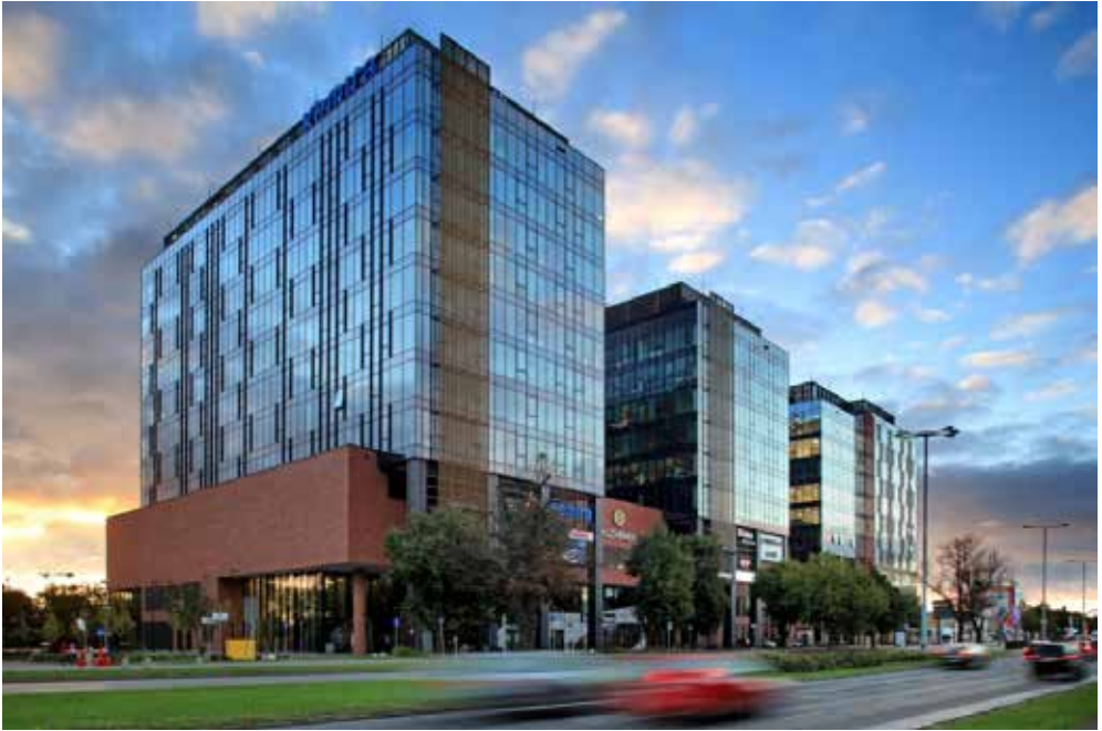
Rysunek 6. Biurowce Alchemia w Gdańsku, proj. APA Wojciechowski, w budowie od 2011 roku (Figure 6. Alchemia office buildings in Gdańsk by APA Wojciechowski, under construction since 2011)
