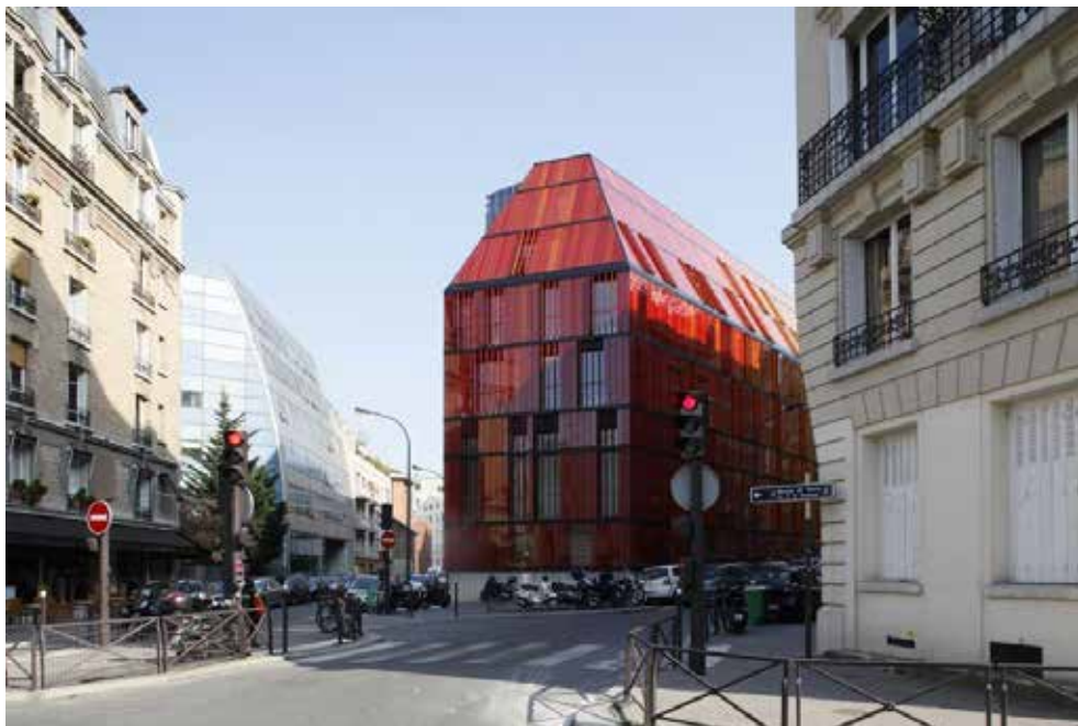
Rysunek 3. Novancia Business School Paris – budynek zrealizowany według projektu A.S Architecture-Studio w centrum Paryża (13 dzielnica) – 2011 r.
