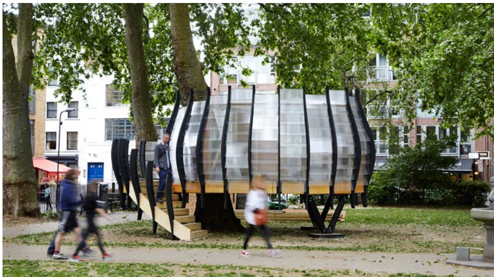
Rysunek 6. TREExOFFICE w Londynie – widok z zewnątrz (Figure 6. TREExOFFICE in London—view from the outsider)
