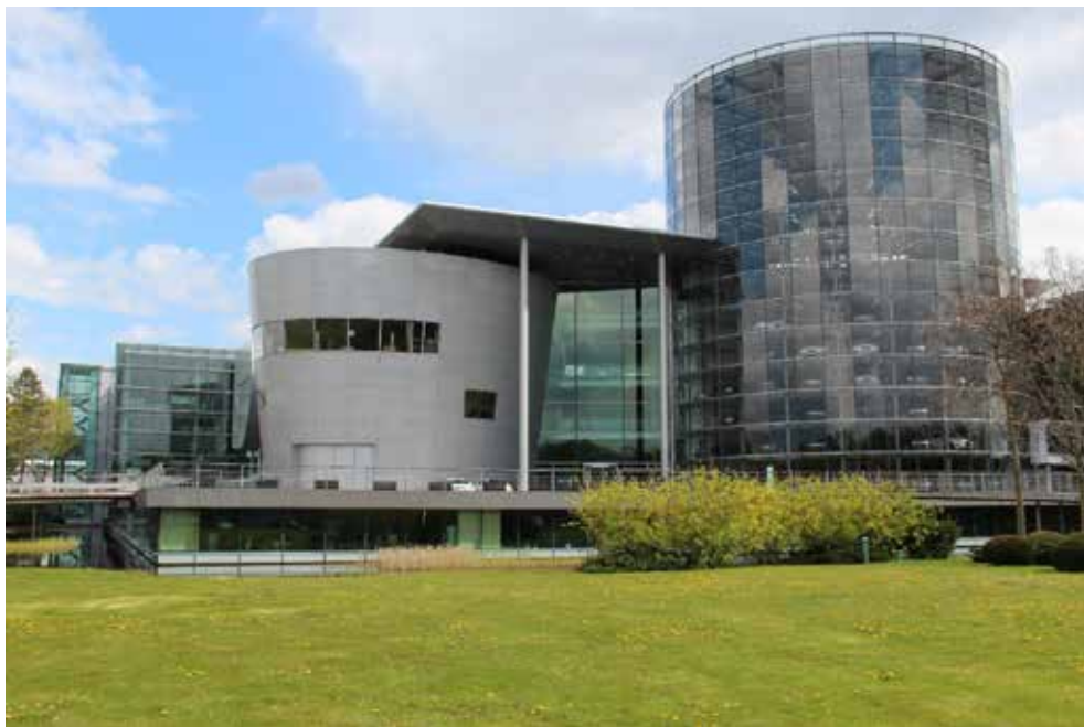
Rysunek 6. Strefa wejściowa montowni koncernu Volkswagen AG w Dreźnie, tzw. Szklanej Manufaktury ( Gläserne Manufaktur ), zrealizowanej według projektu Guntera Henna z zespołem, w 2001 roku (Figure 6. The entrance zone of the Volkswagen AG assembly plant in Dresden, aka Glass Manufactory [ Gläserne Manufaktur ], completed according to Gunter Henn and partners' project, in 2001)
